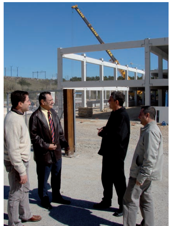
L'equip de govern visita les obres avançades dels nous col·legis
